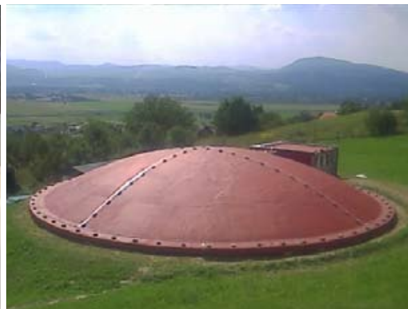
STF ® fasadna obrada vodospremnice kupolaste građevine pokraj grada Zaprešića prema projektu Miljenka Strabić. dig, iz Zavoda za zgradarstvo IGH, Zagreb (desno) i zaobljene krovne fasade građevine u Bijeničkoj ulici, Zagreb, predočava izrazitu prednost STF ® - tehnologije za izvedbu segmenata ili cijele toplinske fasade složene geometrije: kupolaste, lučne, cilindrične, hiperbolne.
