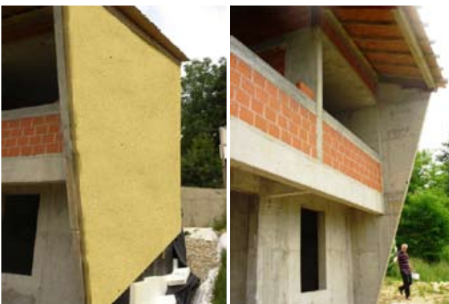
Početak izvedbe STF ® -duo fasade na obiteljskoj vili Kanjera, na padini Strahošćak Zelena magistrala, Zagreb, prema projektu uglednog hrvatskog arhitekta Davorina Raos iz projektantske kuće Forum.
