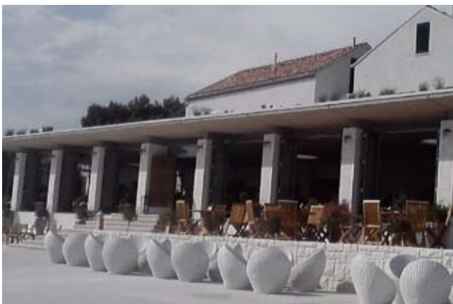
STF ® -fasada na više objekata marine Žakan, Kornati (2011.) u završnoj vizuri jedinstvene tradicijske rustikalne dalmatinske (klasične) fasade – prema prestižnom projektu studija Rusan-arhitektura iz Zagreba.
